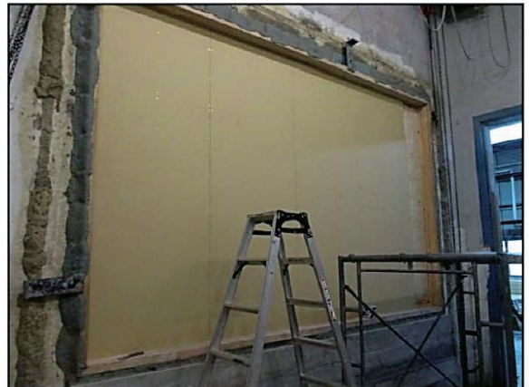
(4) 下貼りせっこうボードの施工状況
