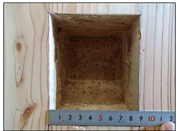
(6) 欠損部の寸法
