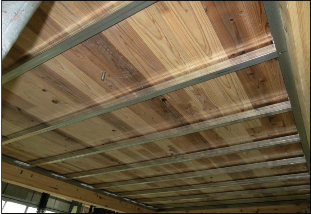
(e) 天井LGSの設置状況
