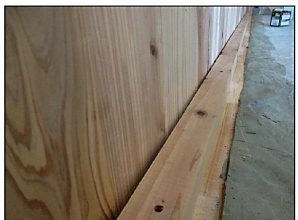
(6) 木下地(t=45mm)の施工状況
