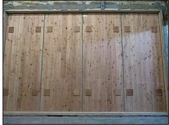
(2) 貫通部の合板塞ぎの状況
