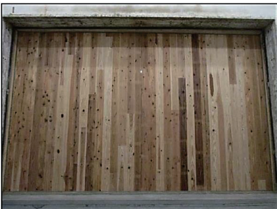
(5) CLTパネル(t=90mm)の取付状況(音源側)
