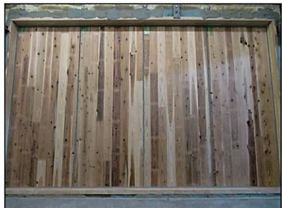
(6) CLTパネル(t=90mm)の取付状況(受信側)
