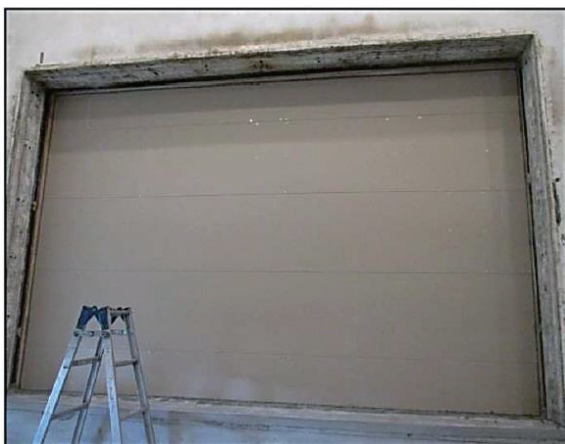
(5) 上貼り強化せっこうボードの施工状況
