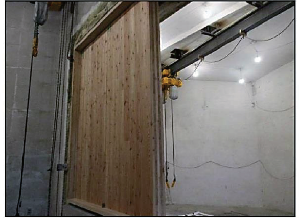
(2) CLTパネル(t=150mm)の取付状況
