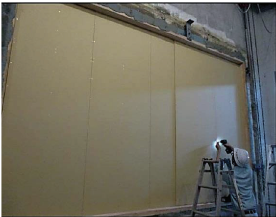
(3) 上貼りせっこうボードの施工状況
