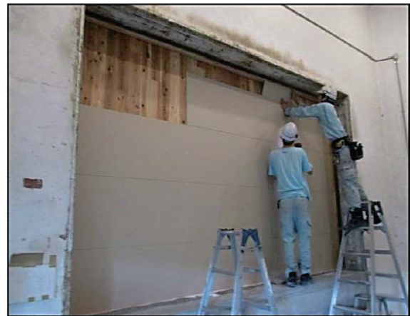
(4) 下貼り強化せっこうボードの施工状況
