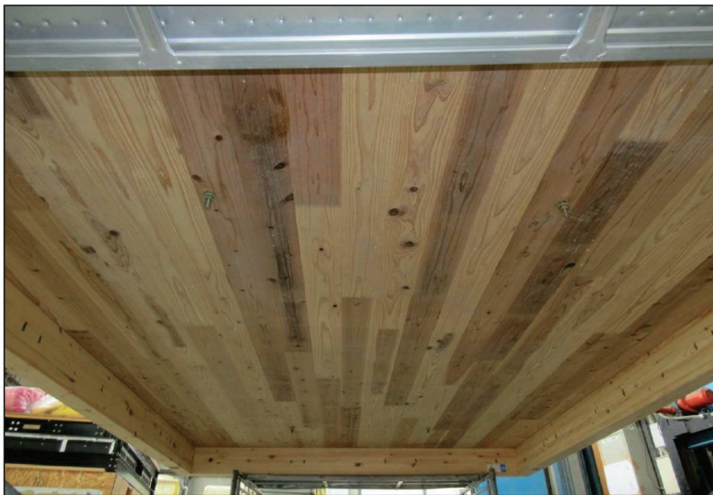
(d) 床CLTパネルの床下側の状況
