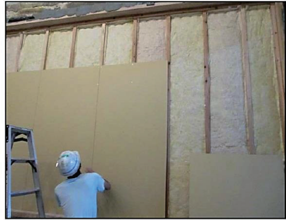
(2) 下貼りせっこうボードの施工状況
