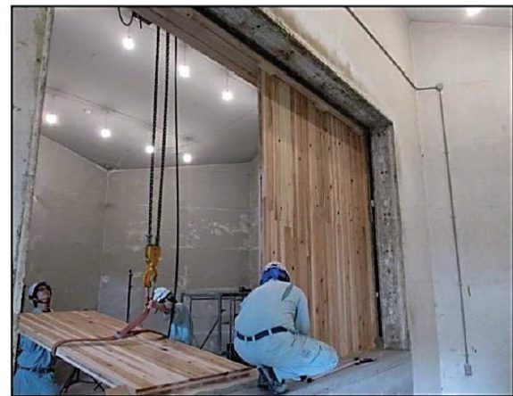
(6) CLTパネル(t=60mm)の取付状況
