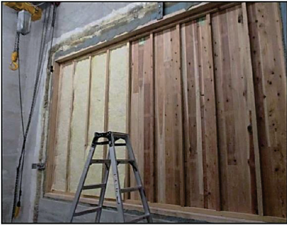
(1) 木下地(t=45mm)およびグラスウールの施工状況
