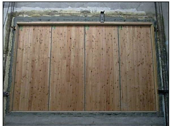
(4) CLTパネル(t=150mm)の取付状況(受信側)
