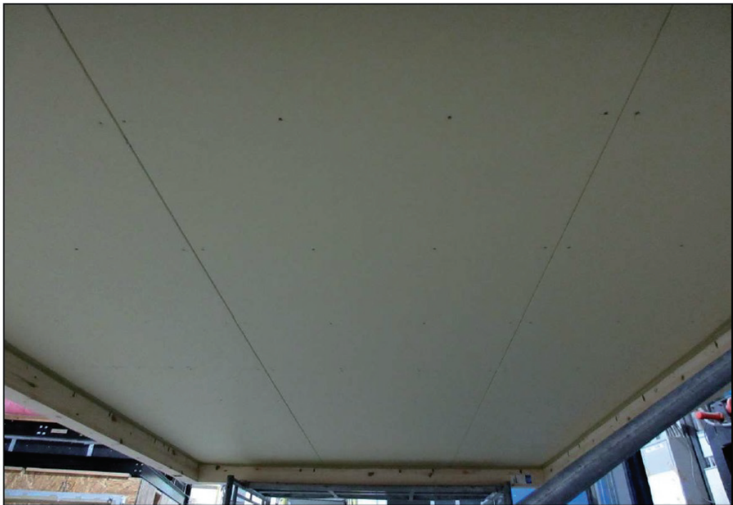
(f) 天井せっこうボードの設置状況
