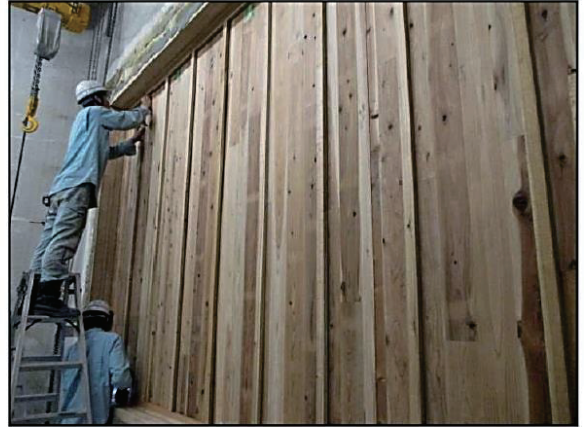
(2) 木下地(t=20mm)の施工状況
