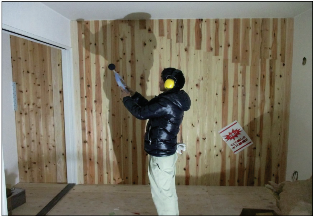
写真 4.3.11 空気音遮断性能の測定状況(調査物件 2 : 福島、測定 No. 5)
