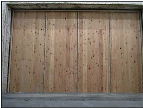
(3) CLTパネル(t=150mm)の取付状況(音源側)
