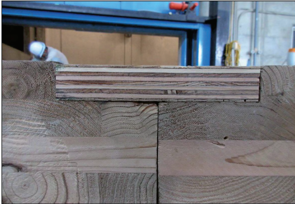
(c) 床CLTパネルのスプライン接合の状況
