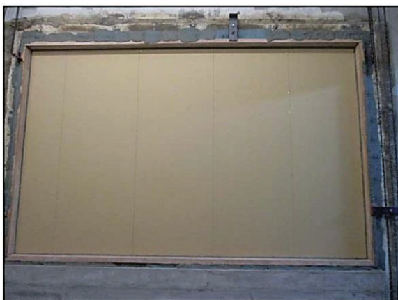
(5) 上貼りせっこうボードの施工状況
