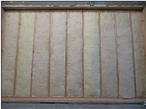
(3) グラスウールの施工状況
