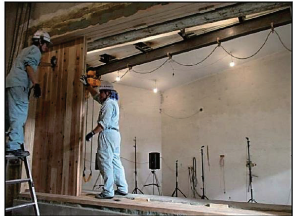
(4) CLTパネル(t=90mm)の取付状況
