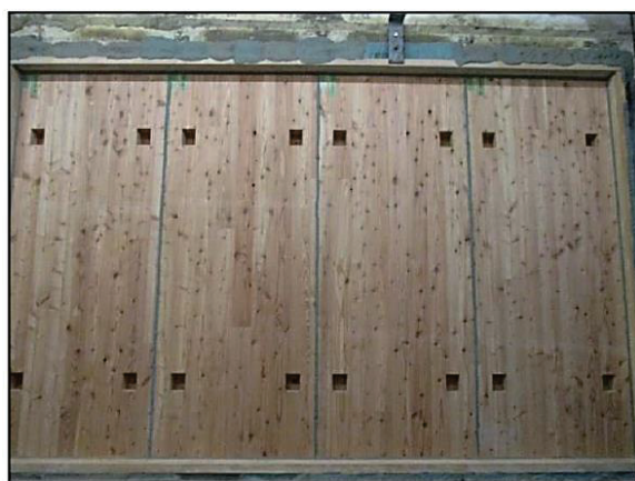
(5) CLTパネルの欠損部の施工状況
