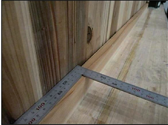
(1) 木下地(t=20mm)の施工状況
