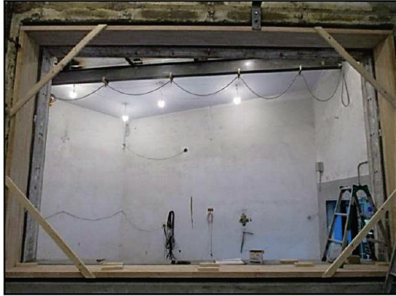
(1) 四周木枠の取付
