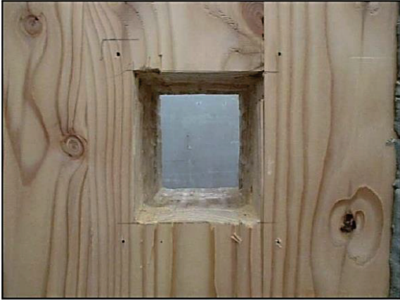
(1) CLTパネルの貫通部の状況
